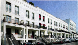
Nach englischem Vorbild und damit optisch einheitlich entstand das Townhouse-Quartier Prenzlauer Gärten . Die Anlage steht auf dem Gelände einer ehemaligen Brauerei mitten im Bötzow-Viertel
