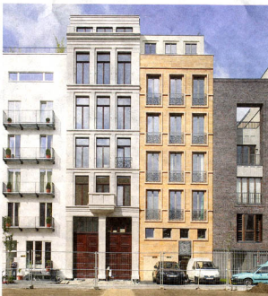
Vielart als Programm: In Außenministeriums-Nähe entstehen schlanke „Townhouses“. Viele Häuser sind schon fertig und bewohnt; der Bauscan im Vordergrund dient dazu, die Grünanlage in der Straßenecke zu schützen
